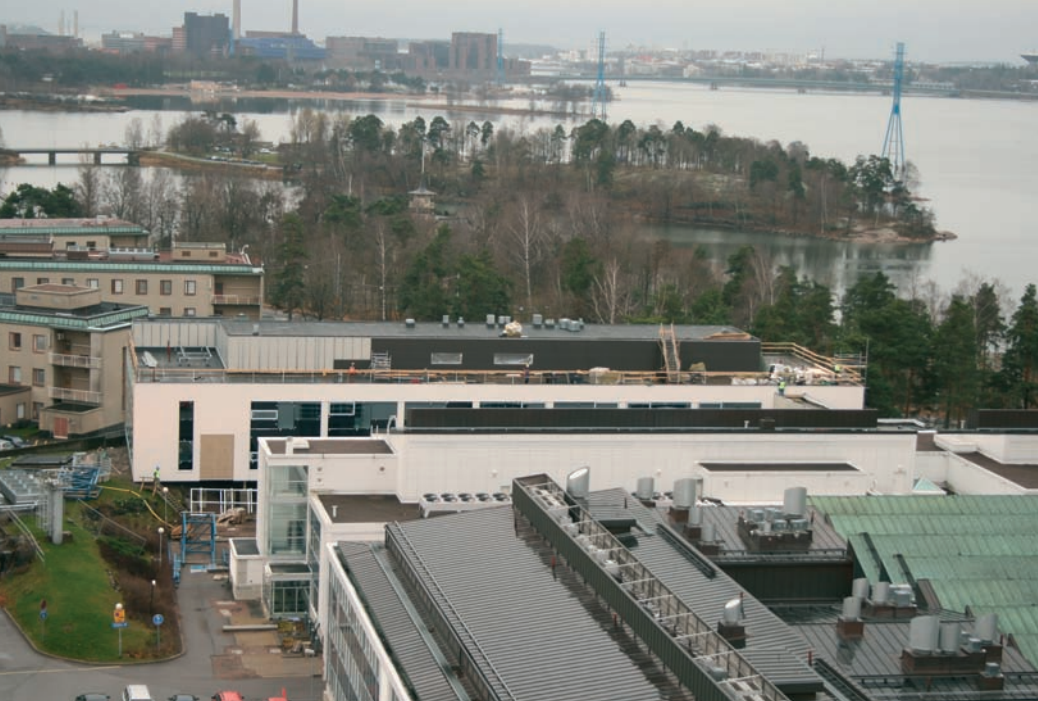
Meilahden väistötilana toimivan parakkisairaalan rakentaminen alkoi syksyllä.
